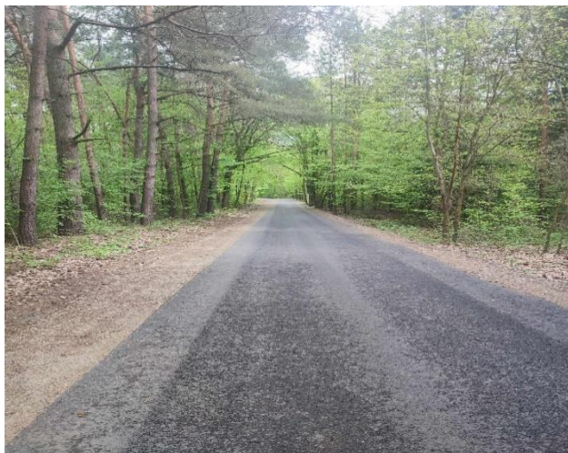
Fot. Wyremontowany odcinek drogi Nr 105108L w Nowym Radzicu
