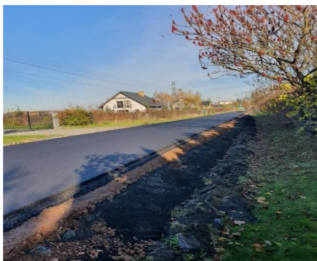
Fot. Wyremontowany odcinek drogi nr 105124L w m. Spiczyn
