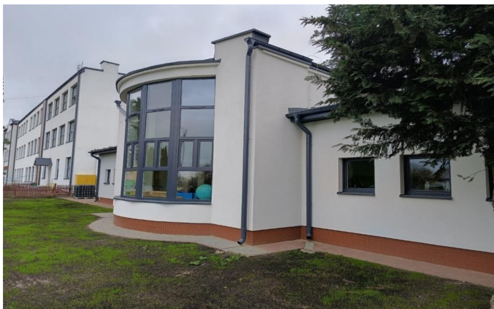
Fot. Budynek Szkoły Podstawowej w Spiczynie po termomodernizacji
