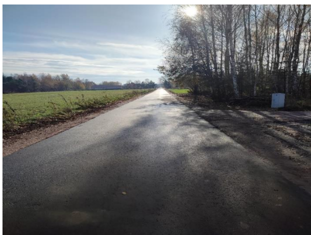
Fot. Przebudowany odcinek drogi nr 105115L w m. Jawidz
