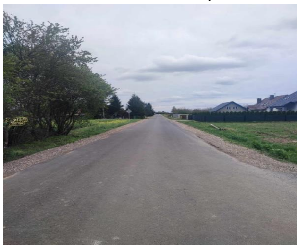
Fot. Przebudowana droga Nr 105107L Zawieprzycy-Kolonia
