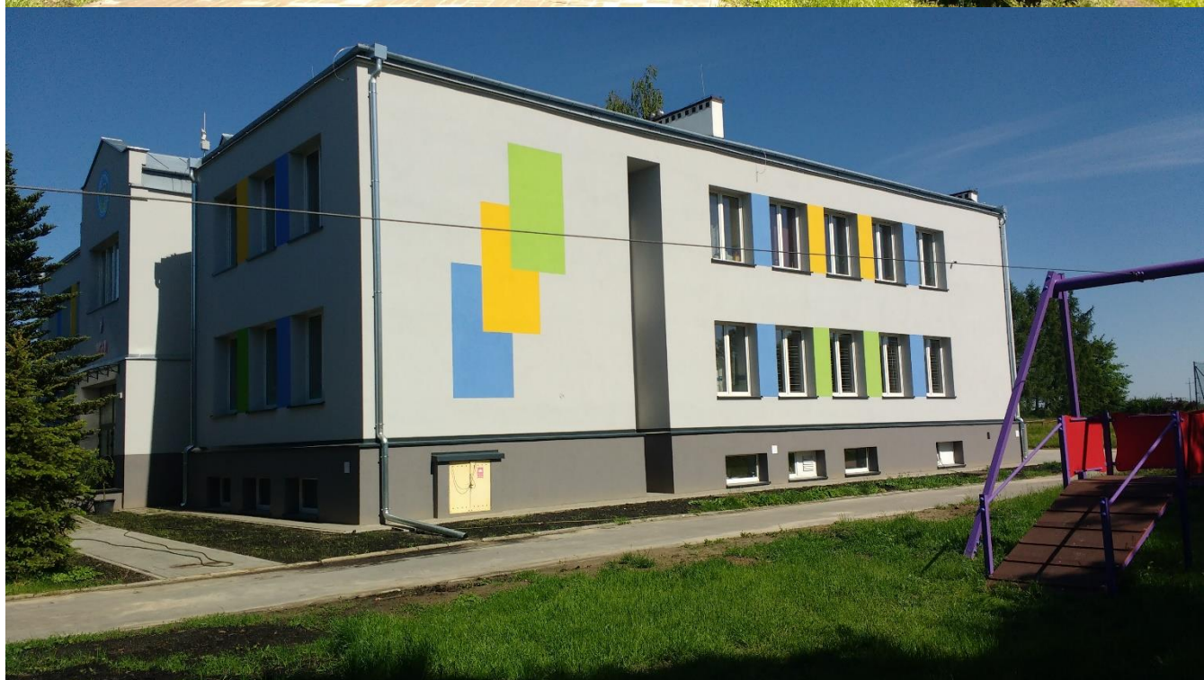
Termomodernizacja budynku SP w Charleżu
